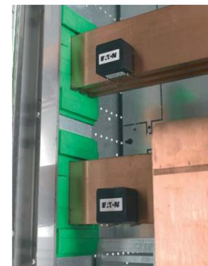
**Система мониторинга температуры** Eaton Diagnose System — управление безопасностью для НКУ. Перегрев внутри НКУ очень часто является причиной выхода его из строя.
